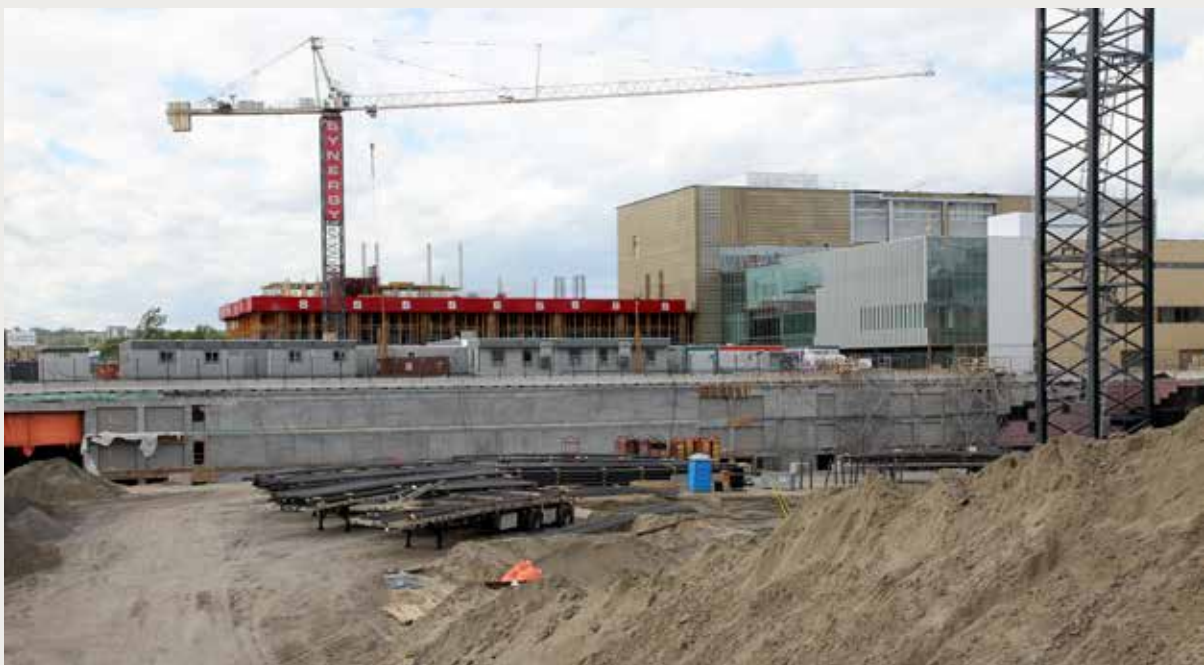
Chantier du nouveau complexe hospitalier sur le site de l'Hôpital de l'Enfant-Jésus à Québec
