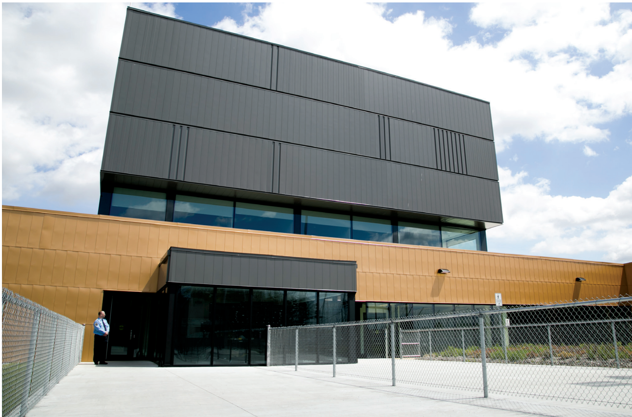
Construction d'un établissement de détention à Sorel-Tracy Photo : Junior Boucher
